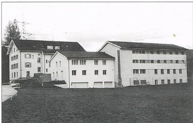
Die Strafanstalt Gmünden wird in zwei Etappen saniert.
